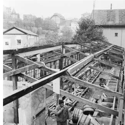
La démolition du lavoir en 1965
