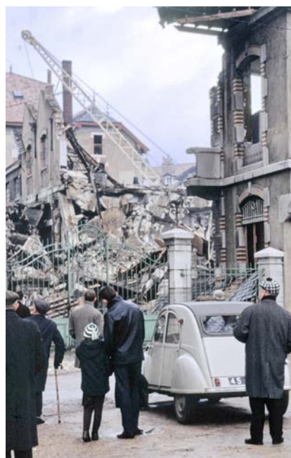
On vient en famille assister à la démolition de la célèbre Gangloff
