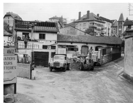
Démontage de la teinturerie Penot. À droite l'ancien tracé, plus sinueux, de la rue Isenbart
