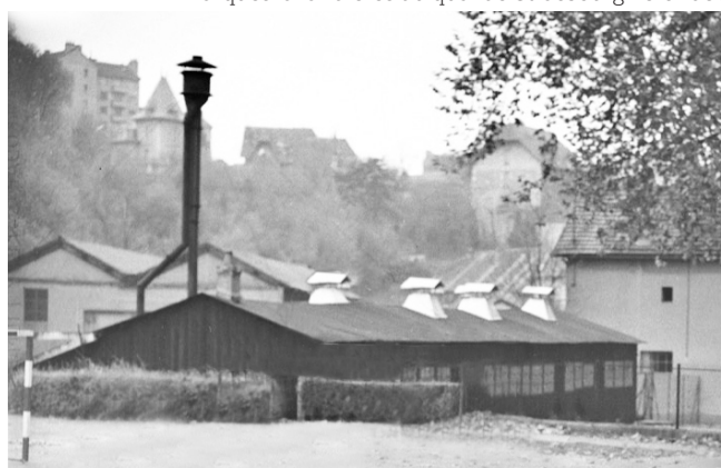
Le lavoir et sa cheminée coiffée d'un fameux filtre fumivore en 1961
